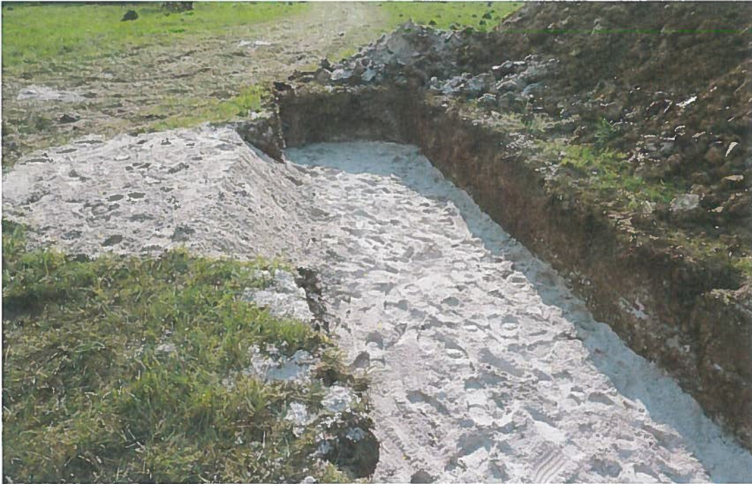
Abbildung 1: Sandlinse und Auskofferung der Steinschüttung (19.04.2016)
