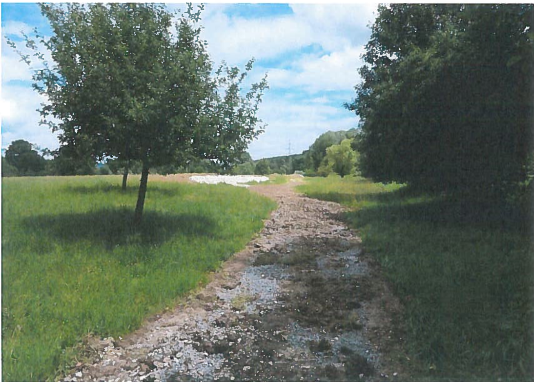
Abbildung 5: Mit Schotter und Erde aufgefüllter Weg (28.06.2016)
