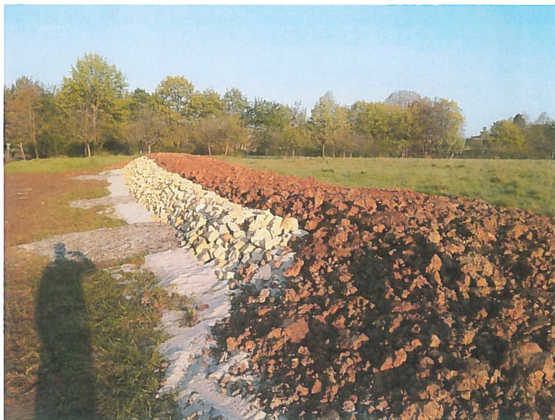
Abbildung 3: Steinriegel mit Erdhinterfüllung (02.05.2016)
